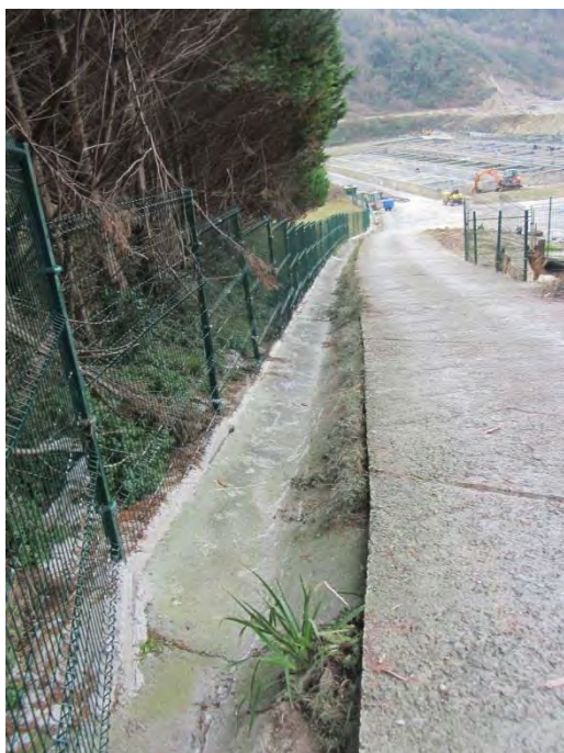
Imagen 6. Cuneta para canalización de escorrentías dentro de Culmanor.
