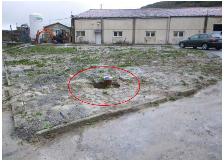
Imagen 1. Dentro del óvalo, boca del pozo de agua salada.
